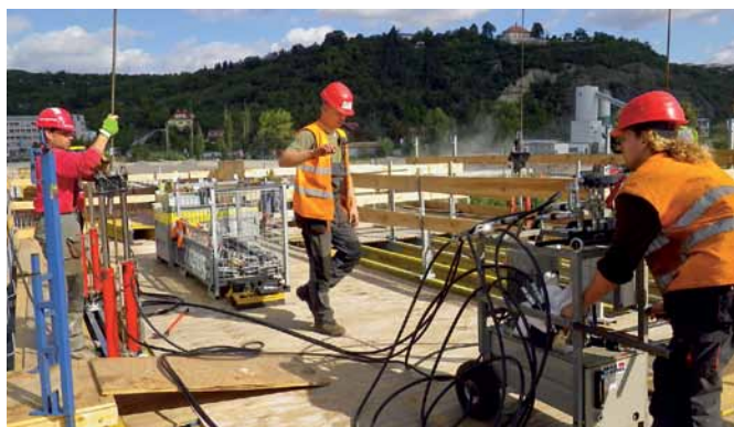
Bednicí stoly (Doka) jsou zvedány pomocí zdvihacích jednotek a výkonného hydraulického agregátu rychlostí přes 10 m/h.
