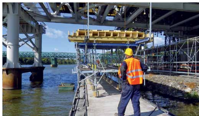
Bednicí stoly jsou zvedány a spouštěny převážně na loď.
