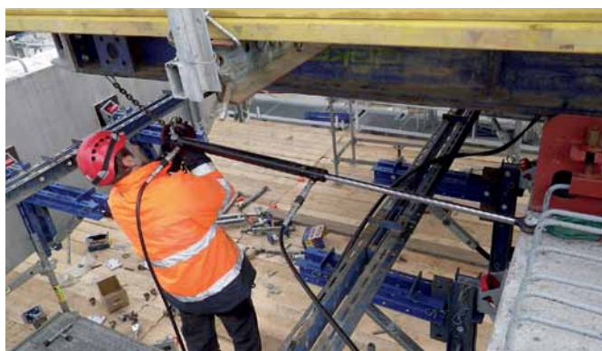
Montáž hydraulického válce pro posuv plošiny
