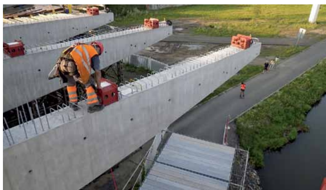
Montáž stoliček pro posuvné plošiny na příčníky mostu
