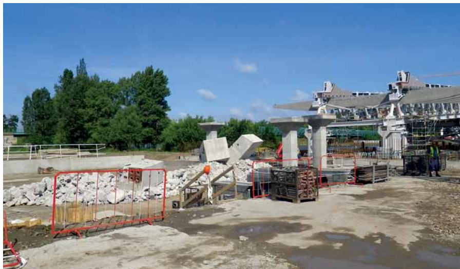
Likvidace výroby v Praze-Holešovicích po dokončení výsunu mostu
