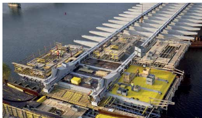
Pohled na tři posuvné plošiny a bednicí stoly na Holešovické straně mostu
